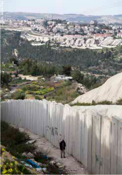
Getrennt vom Land: 80 Prozent der israelischen Sperranlage verlaufen nicht auf der international anerkannten Grünen Linie.
